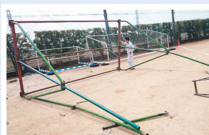
防球フェンス修理
