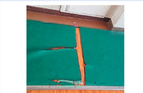
体育館床シート補修
