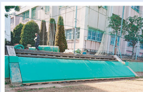
防護マット取付・修理
