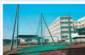
野球場天井幕修理
