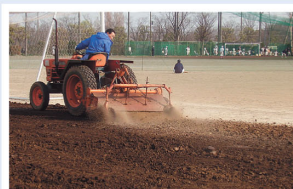
グラウンド改修工事
