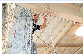
体育館仕切りネット修繕
