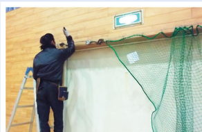
非常口ネット取付
