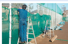
防風・防砂ネット取付
