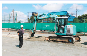
テニスコート改修工事
